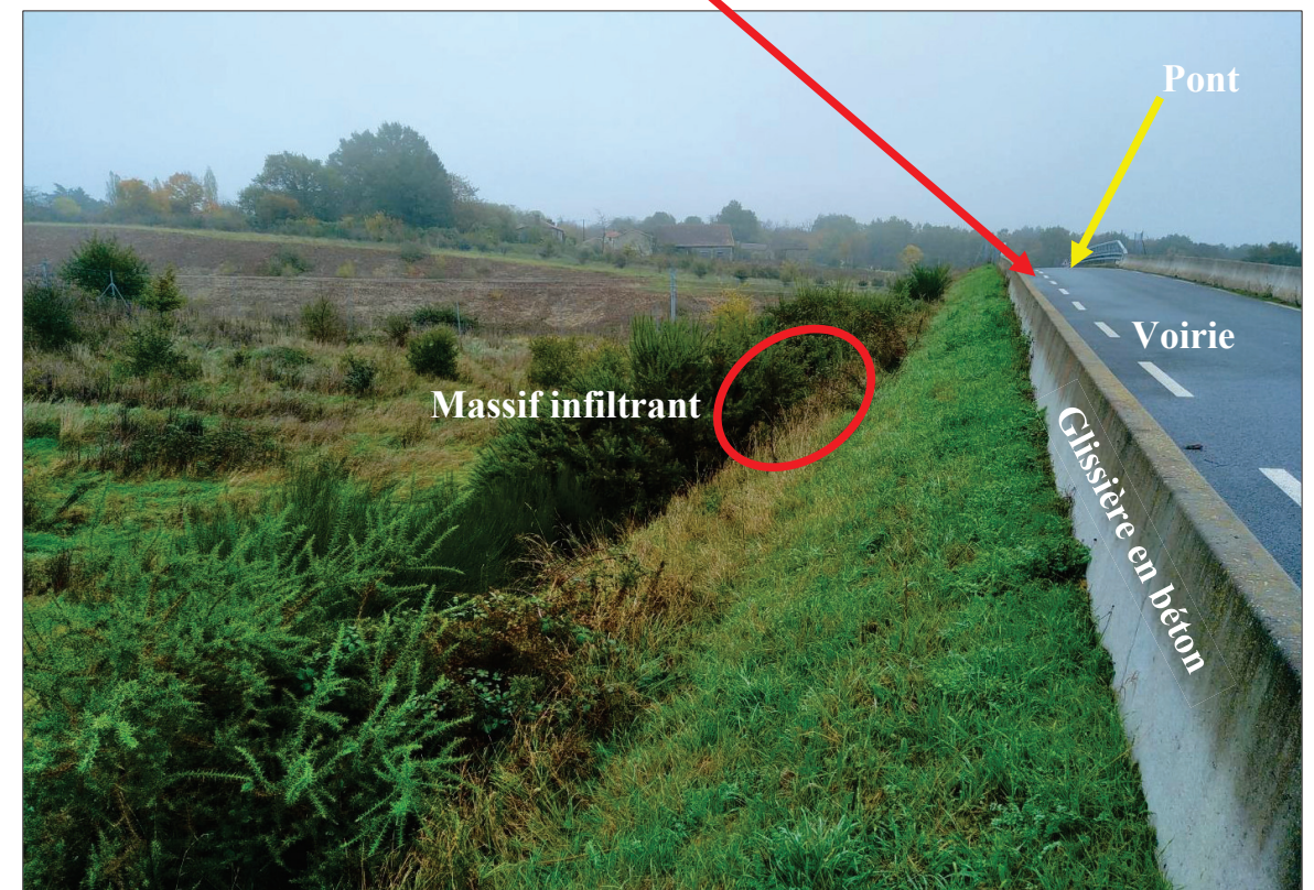
Figure 12 : Illustrations photographiques d'un avaloir et d'un massif « infiltrant » recouvert par la végétation, observés le 03/11/2021
