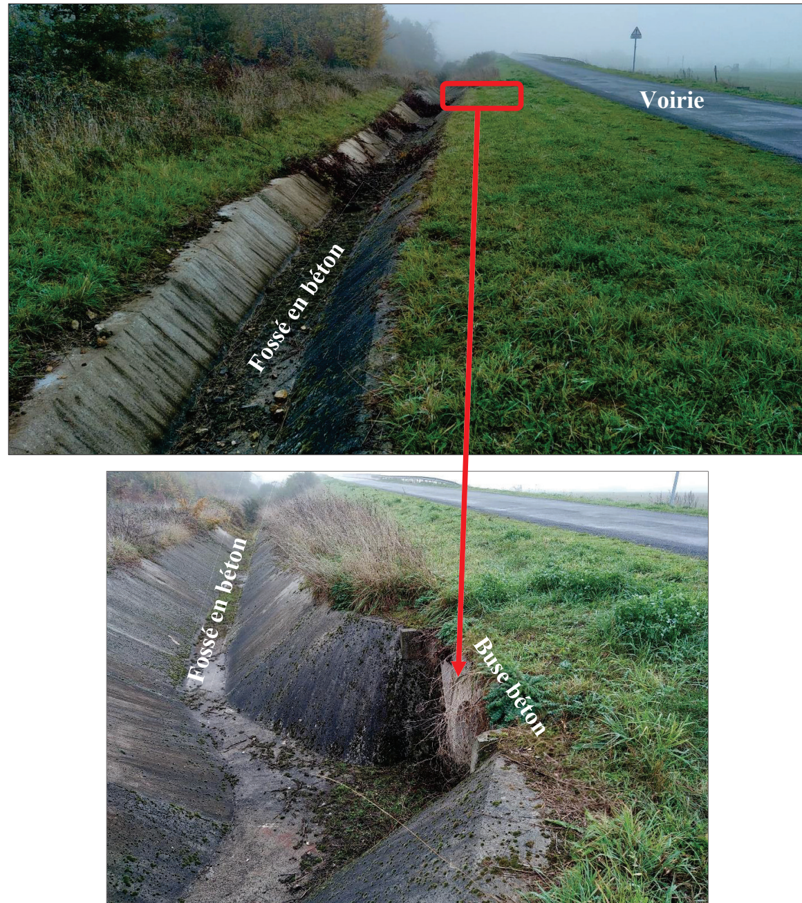
Figure 13 : Illustrations photographiques du fossé béton et de la buse béton, observés le 03/11/2021
