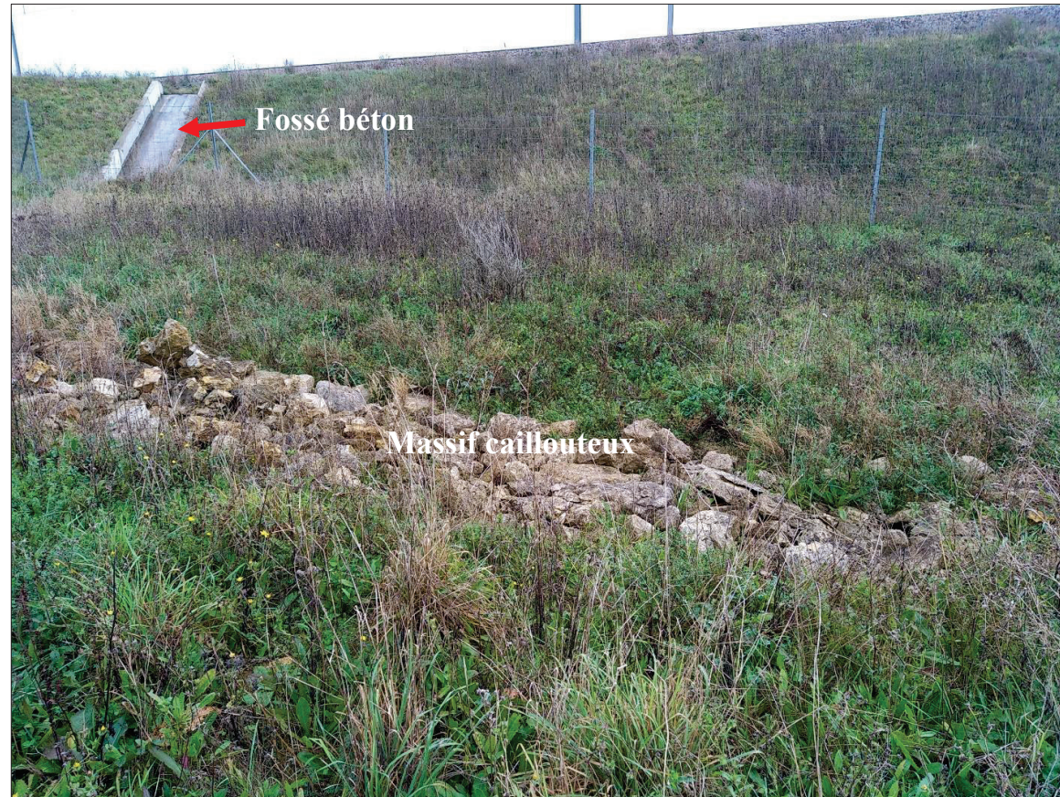
Figure 17 : Illustration photographique du fossé béton et du massif caillouteux, observés le 03/11/2021
